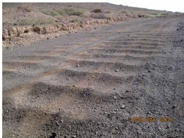
Ilustración 30.- Rizos u hondas transversales sobre el firme de los viales.
