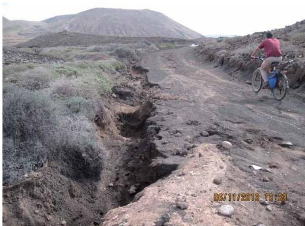
Ilustración 29.- Daños en la cuneta de un vial.
