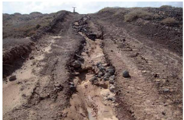
Ilustración 25.- Detalle de cárcavas producidas por lluvias en los viales.
