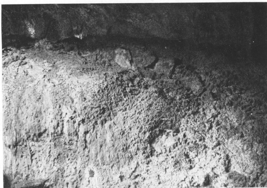
Foto núm. 6.—Aspecto de las paredes del interior de la Cueva de los Naturalistas.
